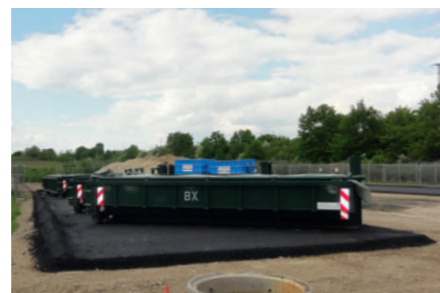
▲ Versiegelte Entwässerungsfläche
