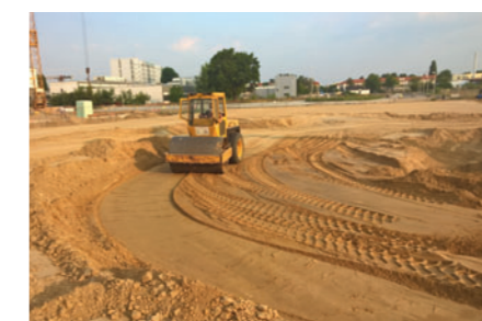
▲ Verfüllung und Verdichtung
