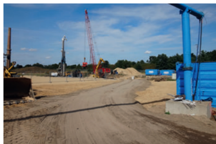
▲ RC-Tragschicht für Großgeräte
